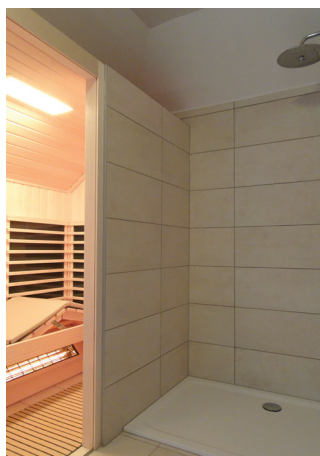
Detail: Verkleidung mit Wandfliesen, bauseits durchgeführt.
