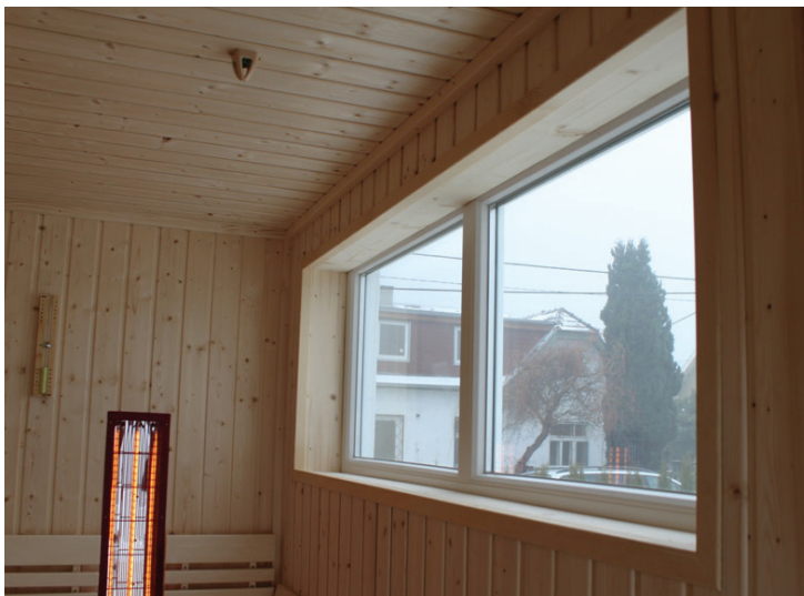
Detail: Fensterlaibung mit Fichtepaneelen („Fenster vorgezogen“).
