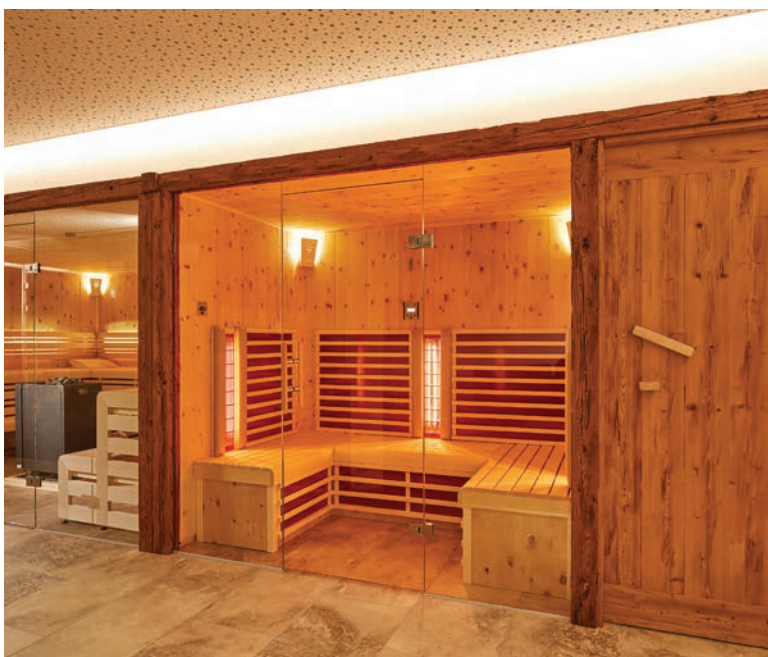
Detail: Große Infrarotkabine mit Glasfront und Altholzrahmen-Verkleidung.
