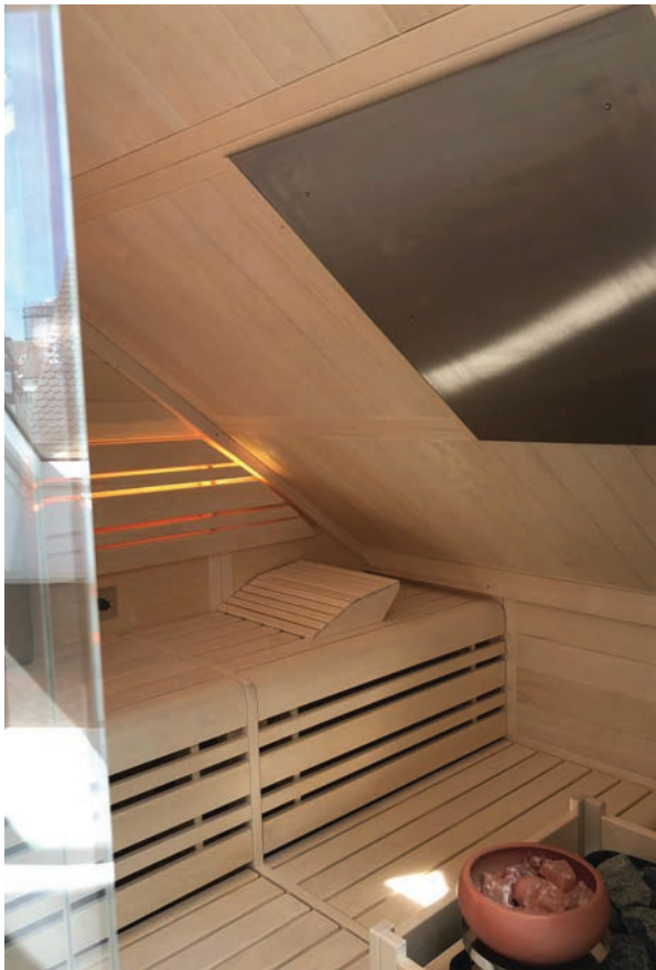
Detail: Um eine mögliche Brandgefahr zu vermeiden, wurde auf der Dachschräge über dem Saunaofen eine Brandschutzplatte montiert.
