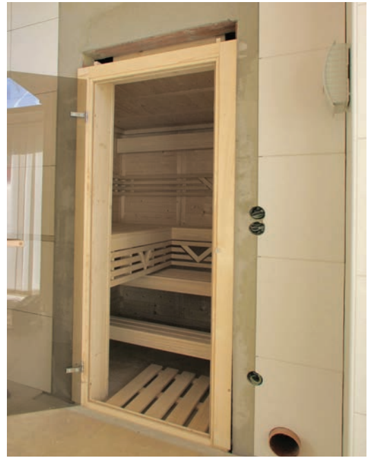
Tür vorgezogen mit Abluftkanal nach vorne
