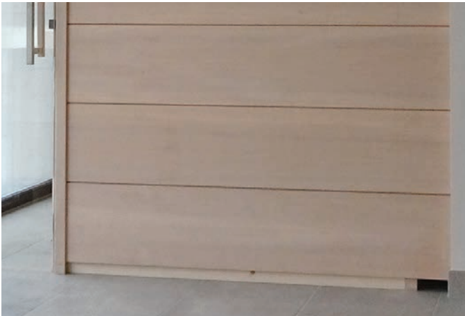
Zuluftöffnung für Hinterbankofen
