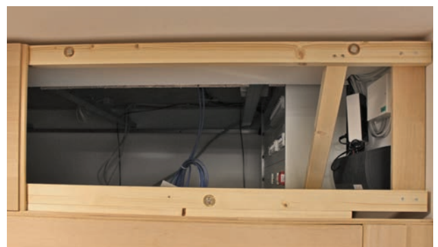
Detail: Revisionsklappe oberhalb der Sauna mit Magneten als Punkthalter.
